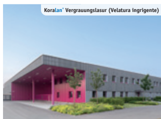
Deposito di materiale Unterföhring, Germania
